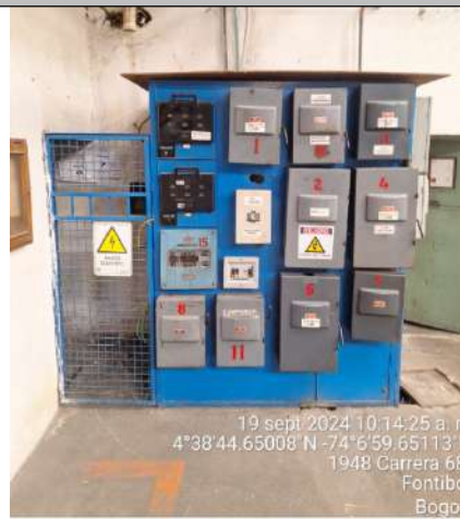
Fotografía 14. Cuarto de subestación eléctrica vacío
