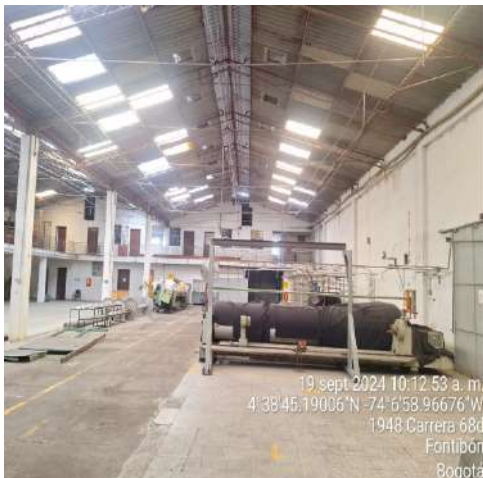
Fotografía 11. Cubierta en asbesto
